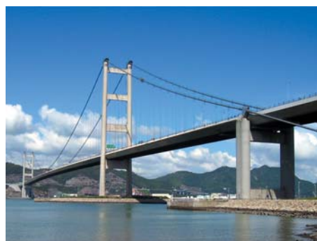
圖5.4 青馬大橋是接連香港國際機場的主要通道
